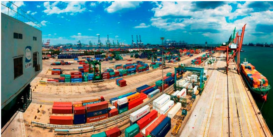
截至 2017 年，公司共有码头泊位 71 个，码头岸线长度 21093 米，设计吞吐能力 36630 万吨，其中集装箱泊位 23 个，散杂货泊位 45 个，其他泊位 3 个。集装箱泊位设计水深最深达-16 米，能够满足世界最大集装箱船停靠。2017 年，公司完成货物吞吐量 39,125 万吨，其中散杂货吞吐量 26,838 万吨，集装箱吞吐量 1,150 万 TEU。
